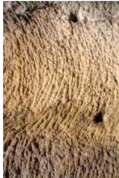
Trace d'escoudes - Tunnel souterrain de Sernhac © Rachel Peltier Muscatelli
