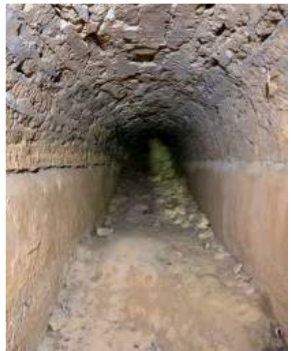
Aqueduc de Nîmes - Tunnel souterrain partiellement comblé près de Bornègre © Sonia Sabatier
