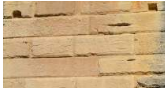
Maçonnerie en grand appareil © Sonia Sabatier
