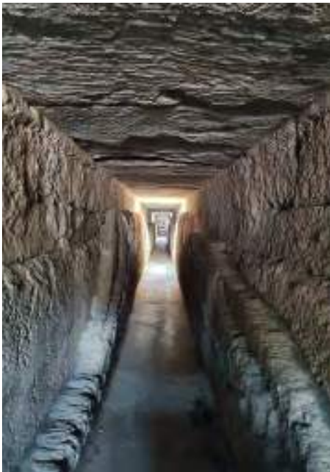
Canalisation (specus) du pont du Gard au niveau supérieur © Rachel Peltier Muscatelli
