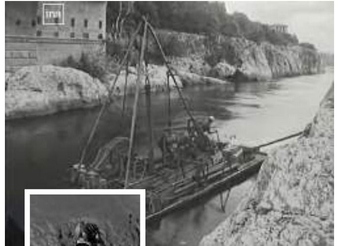
Renforcement des appuis rocheux du pont, 1966 © INA
