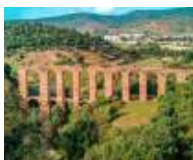
PONT DE CHABET ILELOUINE (ALGÉRIE) Hauteur : 33 m Longueur : 137 m AQUEDUC DE CHERCHELL Longueur : 35 km
