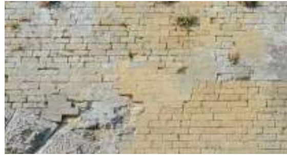
Maçonnerie en petit appareil © Sonia Sabatier
