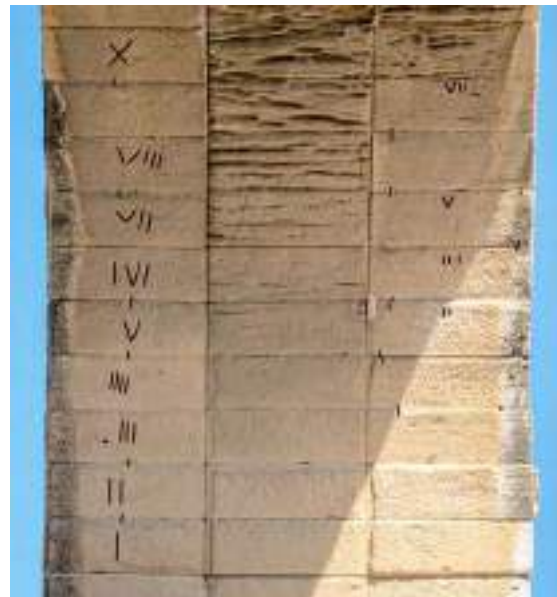
Mise en évidence des repères de positionnement des claveaux des voûtes du second niveau du pont du Gard © Rachel Peltier Muscatelli
