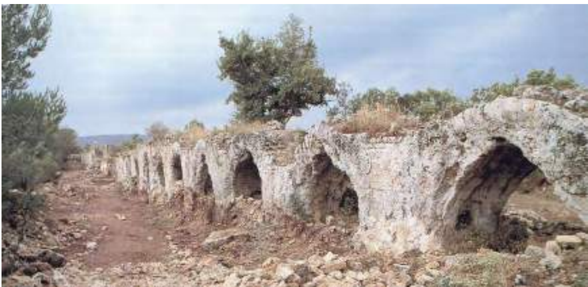
Pont à arcades continues de La Lône © Jean-Louis Paillet
