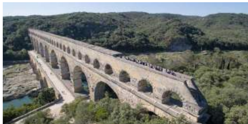
Pont du Gard © François Allaire
