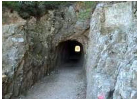
Tunnel creusé sur la rive droite du Pont du Gard © RPM
