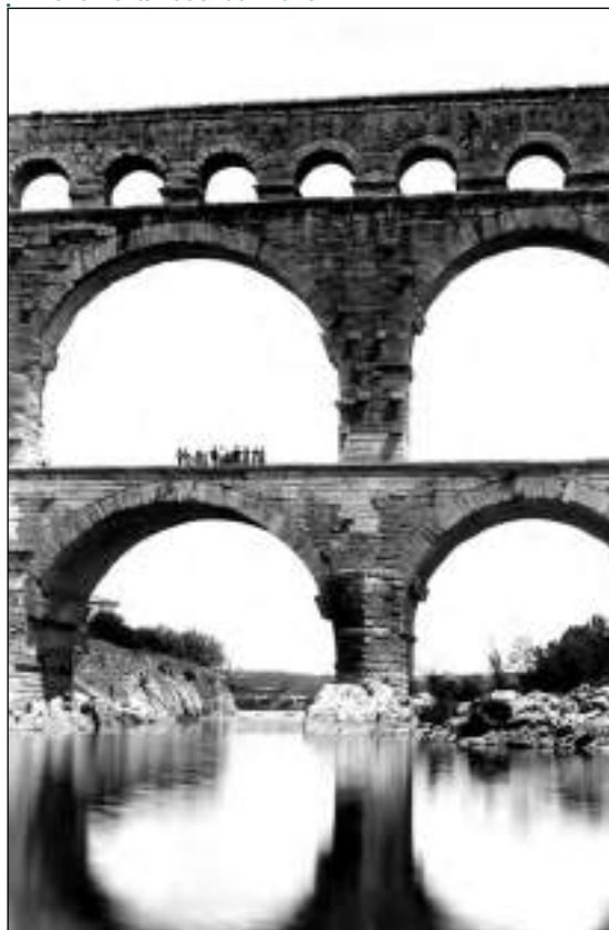
Pont du Gard, Eugène Lefèvre-Pontalis © Centre des monuments nationaux Paris
