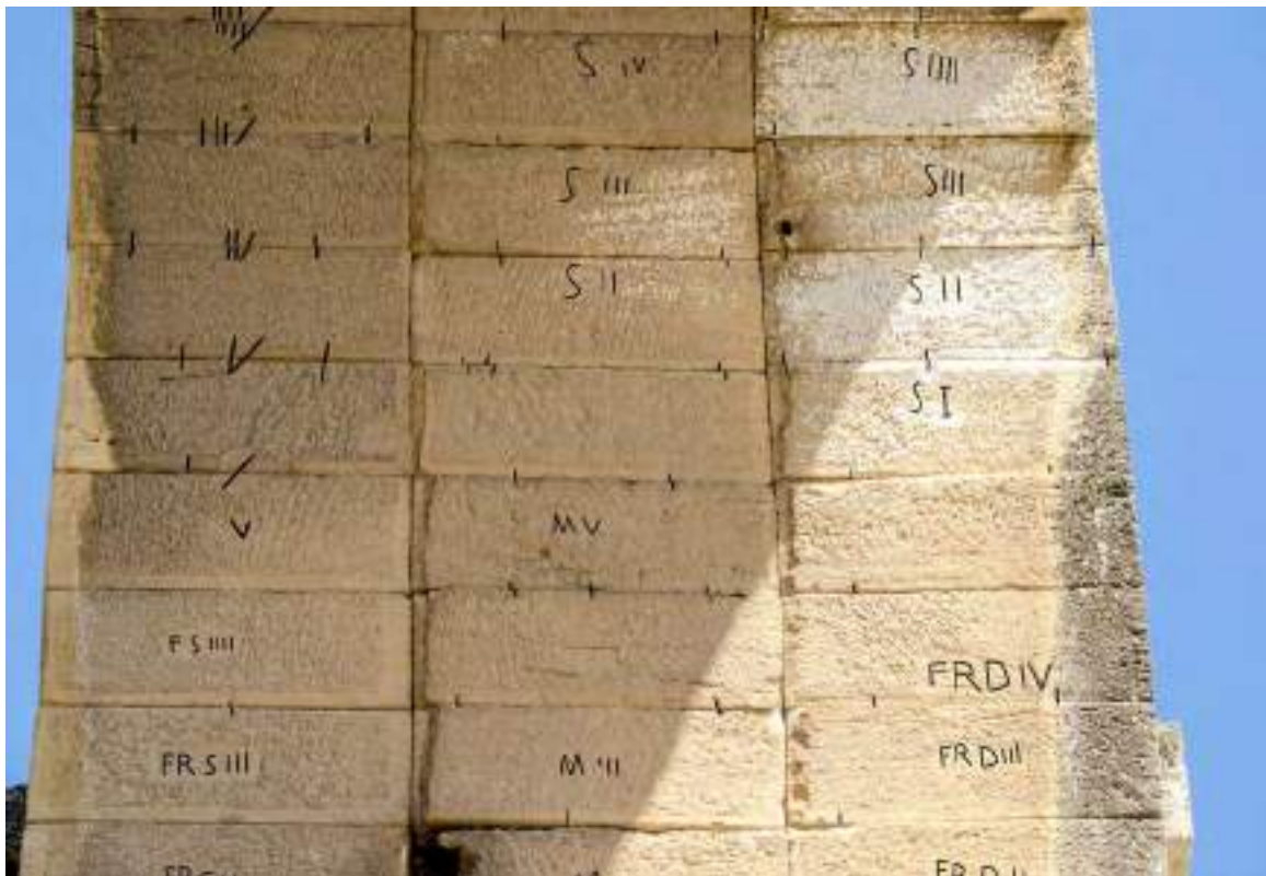
Mise en évidence des repères de positionnement des claveaux des voûtes du second niveau du pont du Gard © Rachel Peltier Muscatelli
