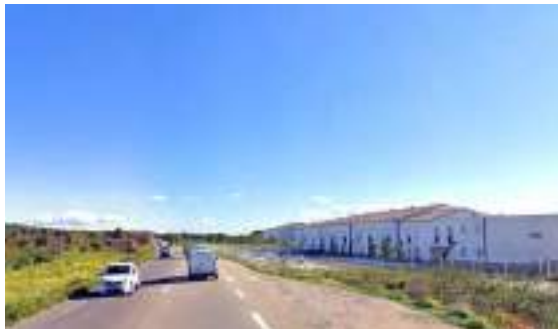
Constructions ne respectant pas "l'esprit des lieux" et déconnectées du paysage, sortie de Marguerittes, 2021 © EPCC
