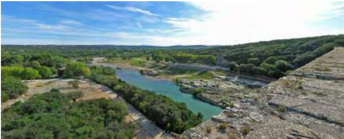
Panorama visible depuis le haut de l'aqueduc © EPCC
