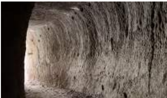
Trace d'escoudes - Tunnel souterrain de Sernhac © Rachel Peltier Muscatelli
