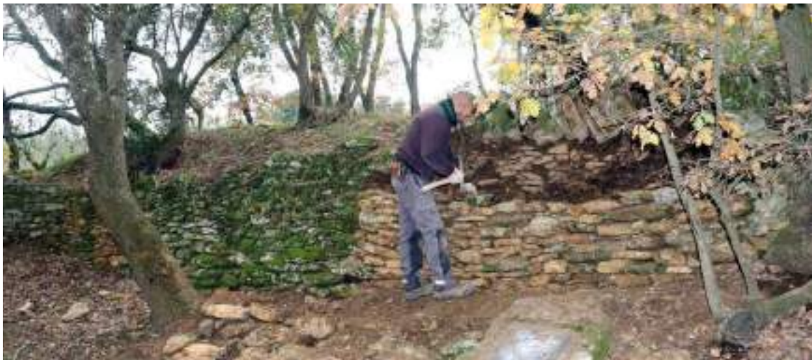
Restoration des murets en pierres sèches par les services techniques du Pont du Gard (gestion courante du site) © Floriane Rebuffat
