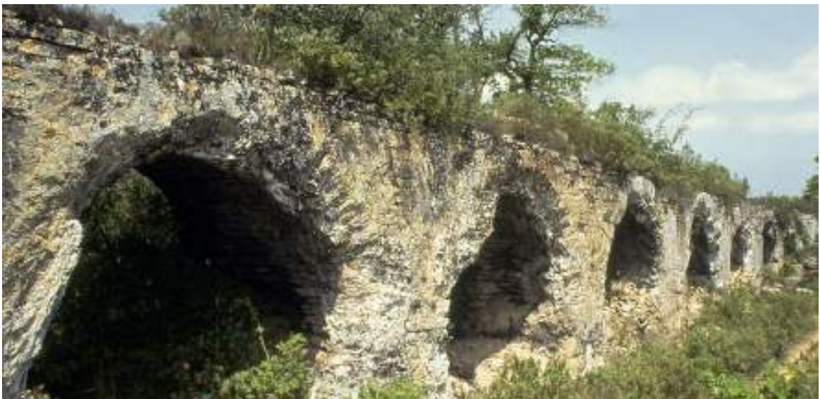
Pont de la Lône © A. Amen
