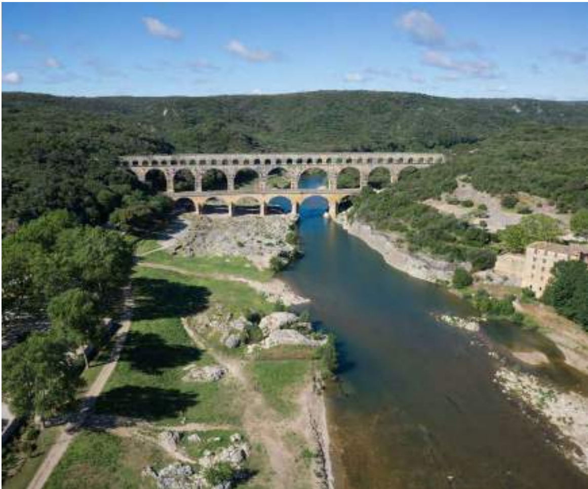
Pont du Gard © François Allaire
